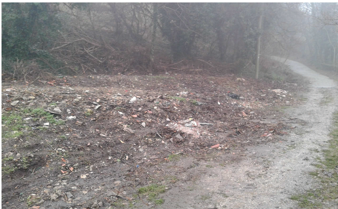
Foto n.1 area cantiere con stradina di accesso
